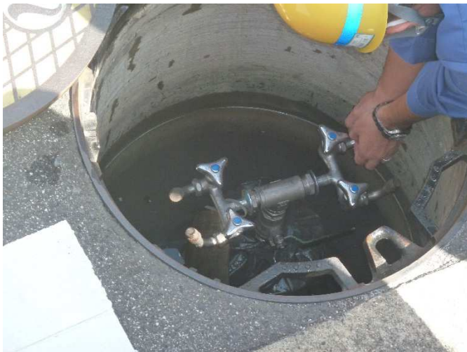
給水栓の取付
