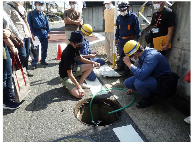
給水ホースの取付
